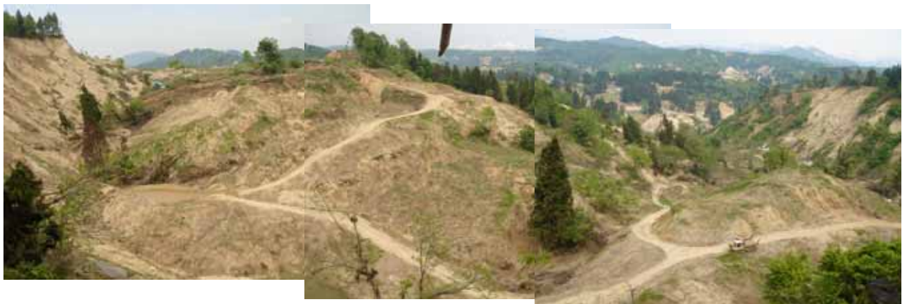
照片五 大日山大型崩坍
