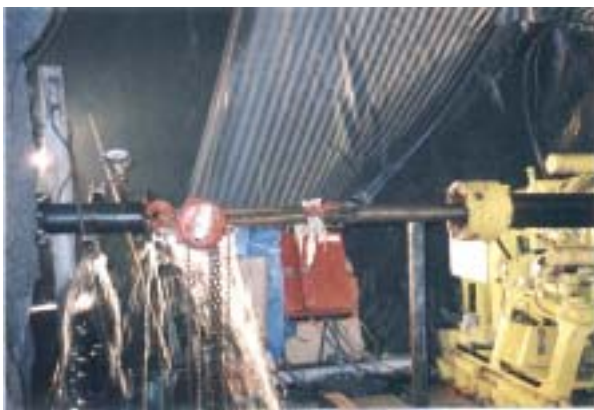
圖 7 大口徑排水孔鑽孔防衝裝置
