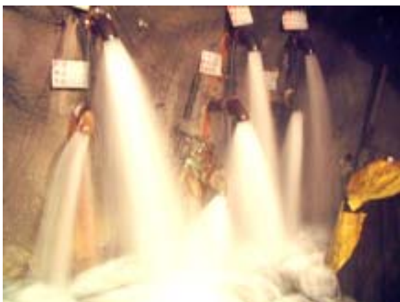
圖 8 NW 線大口徑排水孔狀況
