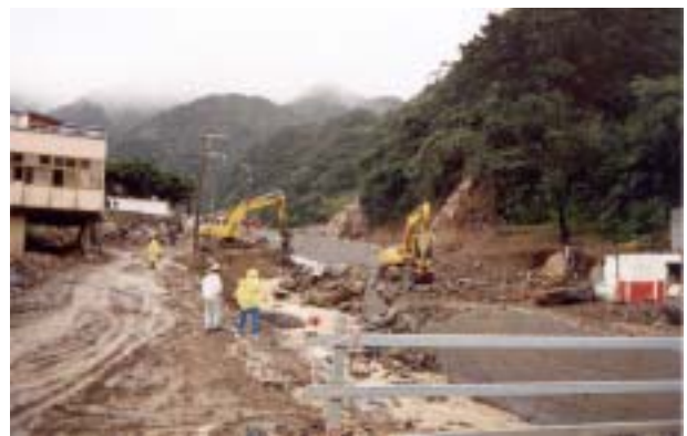
照片 1 瑞芳侯硐大粗坑溪土石流災後處理情形 (王國隆 攝)
