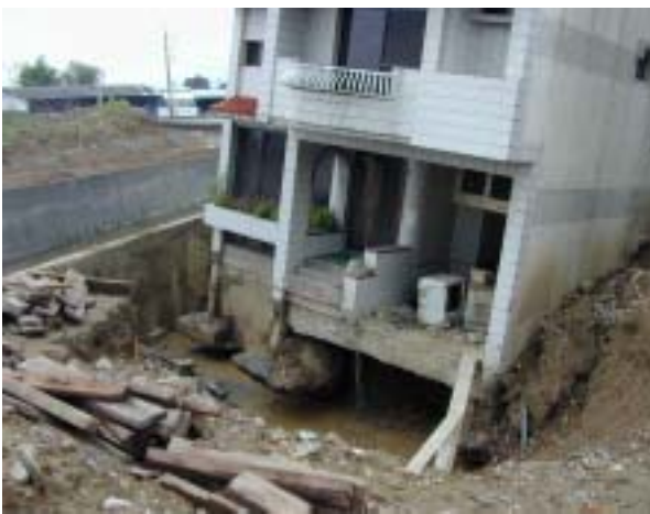
霧峰地區二層建物扶正案例：(1)前側挖空
