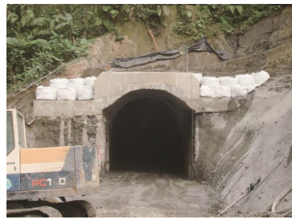
導水隧道出口假洞
