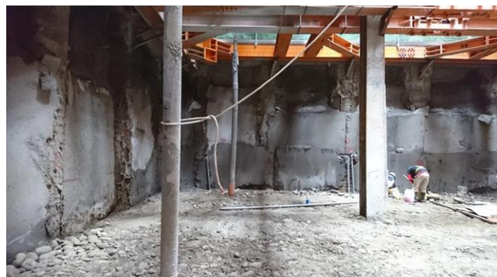
壁面安裝PVC管將水體導入鄰近抽水井
