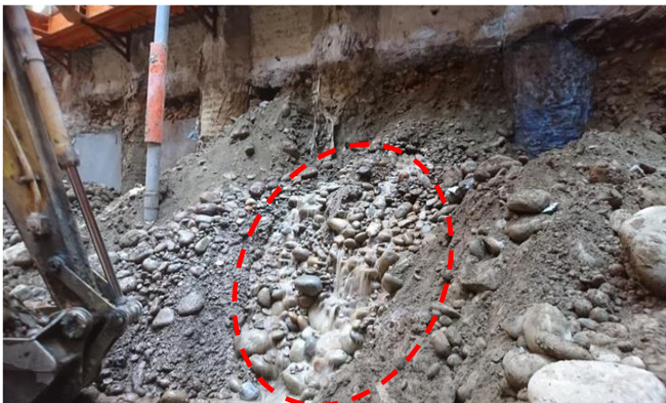
即使地下水位觀測已低於開挖面 開挖過程仍有滲流水湧出
