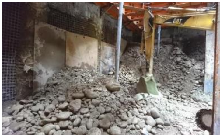
利用鋼板擋土進行背填灌漿
