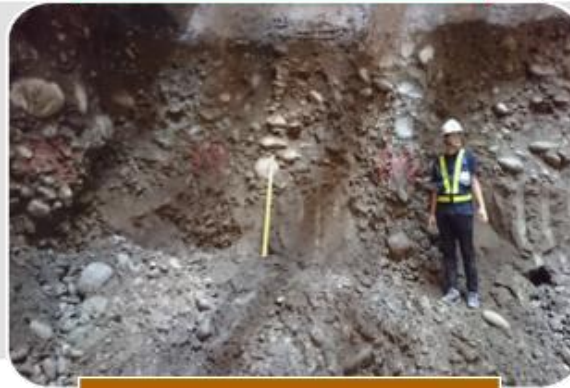
開挖發現局部 細砂層
