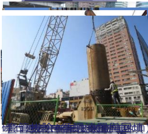
吊圓形鋼筋籠吊放 並安裝特密管
