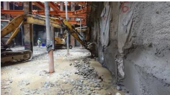
開挖邊溝進行滲流水導排
