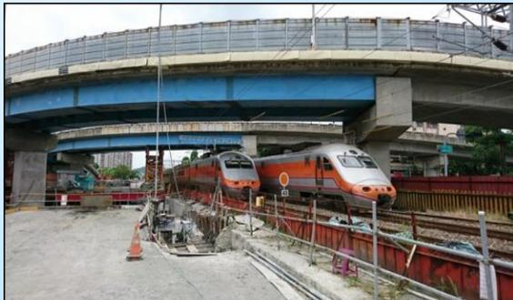
擋土壁接縫止水灌漿及列車慢行
