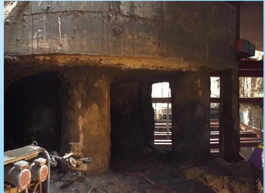
利用連續壁提供承載進行橋墩托底 (完成後低震動切樁)
